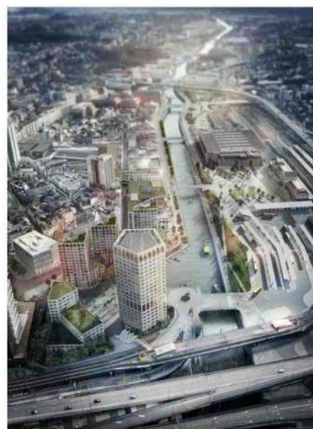
M-G.D. Les travaux préparatoires vont être lancés. © Eiffage
