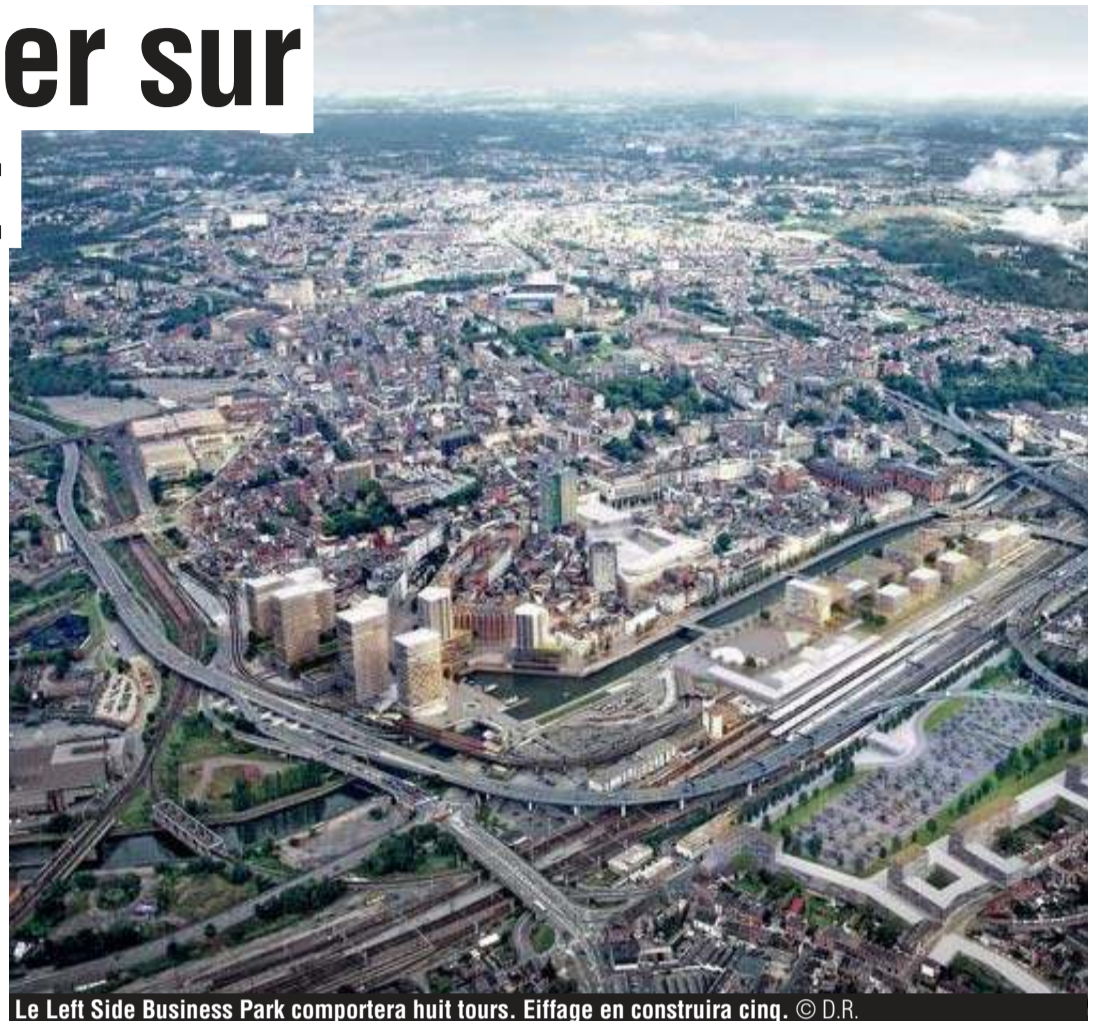
Le Left Side Business Park comportera huit tours. Eiffage en construira cinq. © D.R.
